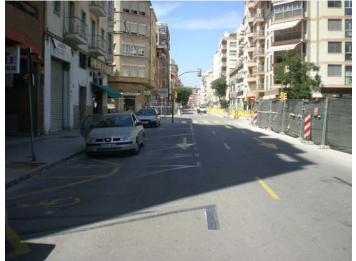
Espacio reducido para operaciones de carga y descarga debido a las obras
