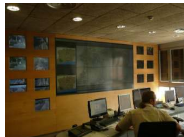
Centrum Kontroli Ruchu w Barcelonie
